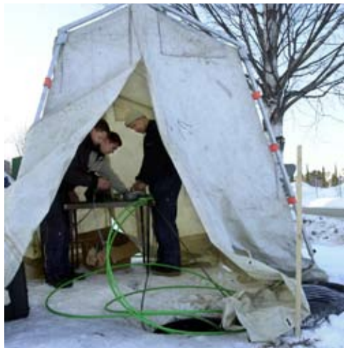
Fiberkabeln grävs ner under en bredbands-satsning i Hudiksvall 2001.
